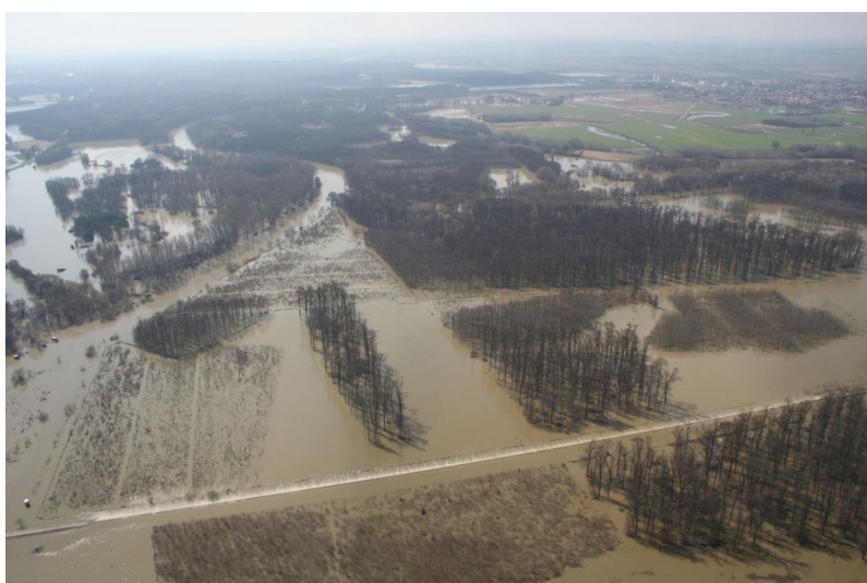
Obr.č.11– přelivný objekt – poldr Soutok
