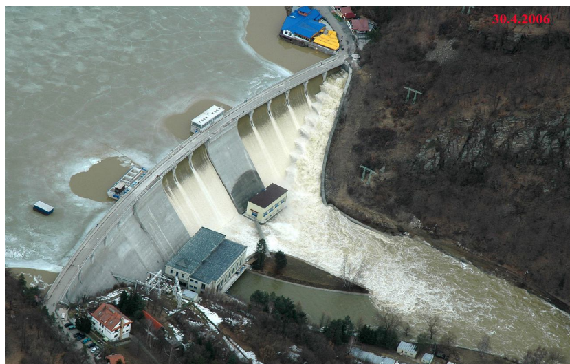
Obr.č.3 – VD Vranov na Dyji při převádění povodně na jaře 2006
