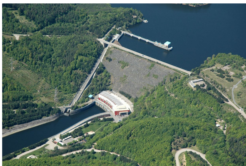
Obr.č.5 – VD Dalešice na Jihlavě
