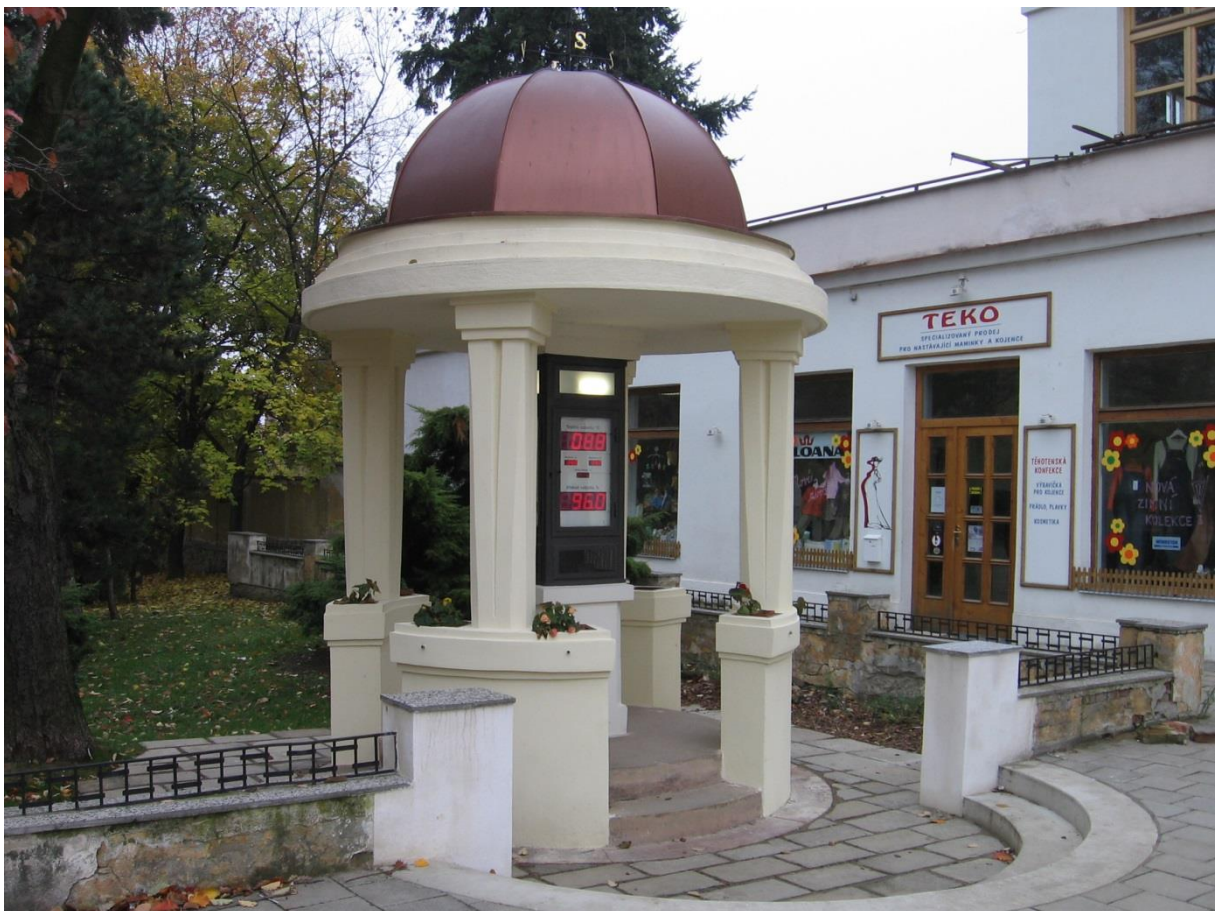
Obr. 3 Stav meteorologického altánku po rekonstrukci v r. 2005
