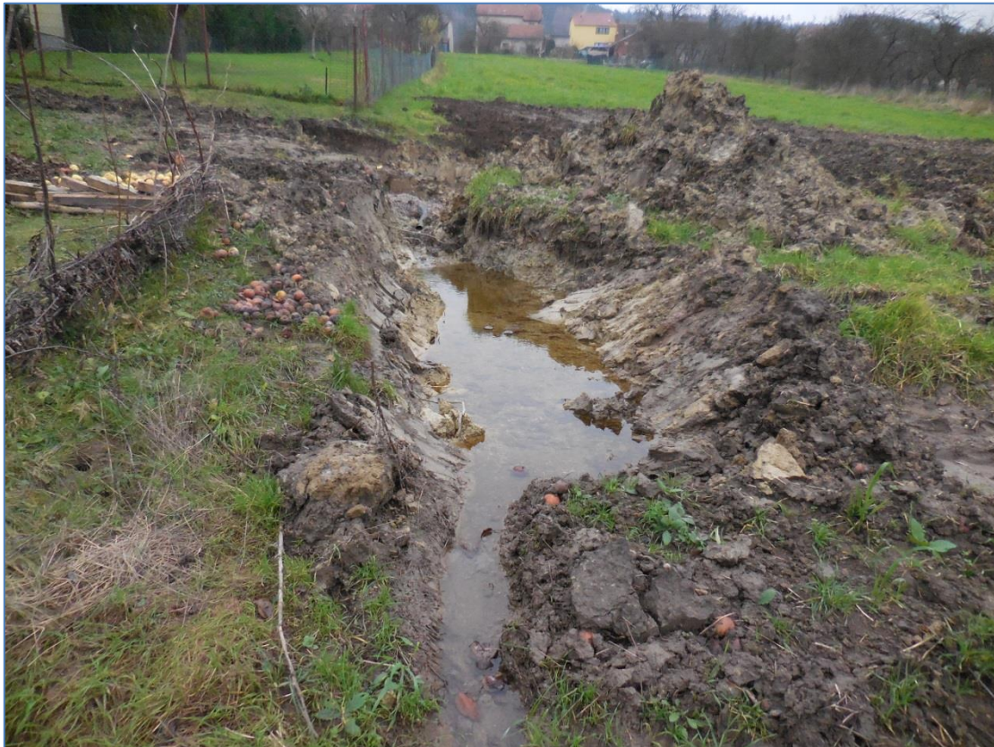
Obr. č. 1: Výtok z drenáže, která byla položena při realizaci kanalizace
