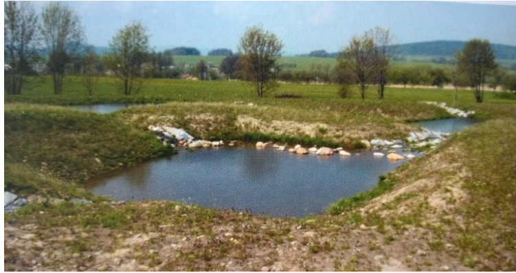
Obrázek 3: Drobné průtočné nádrže vybudované v návaznosti na pozemkové úpravy v okrese Jeseník, zamezují erozi půdy a zpomalují odtok povrchové vody (foto archiv ÚPÚ MZe).
