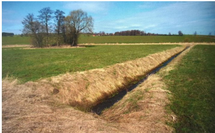
Obrázek 2: Soustava odvodnění zamokřených ploch, jejich účelem bylo zvýšení produkčního potenciálu půd, katastr obce Čechtice (foto archiv ÚPÚ – MZe 1990).
