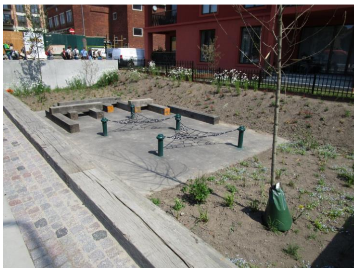
Obr. 9. Nově založené hřiště se zaústěním dešťového svodu z obytné zástavby. Závlahy čerstvě vysázených stromů www.treegator.com
