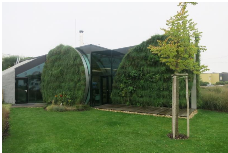
Obr. 5. Budova LIKO-NOE, Slavkov u Brna, zelená fasáda se zavlažováním kapkovacím potrubím z povrchové nádrže.
