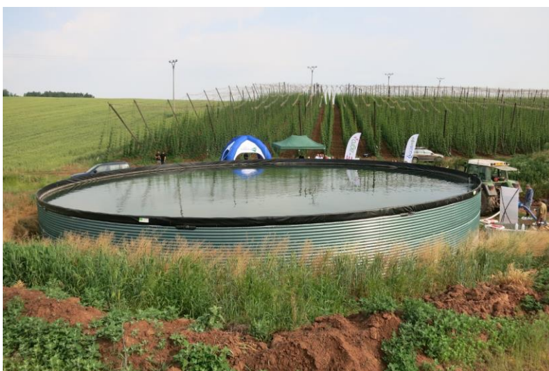
Obr. 4. Montovaná nádrž Genap, Kozojedy, Den chmele AquaHop 16.6.2017
