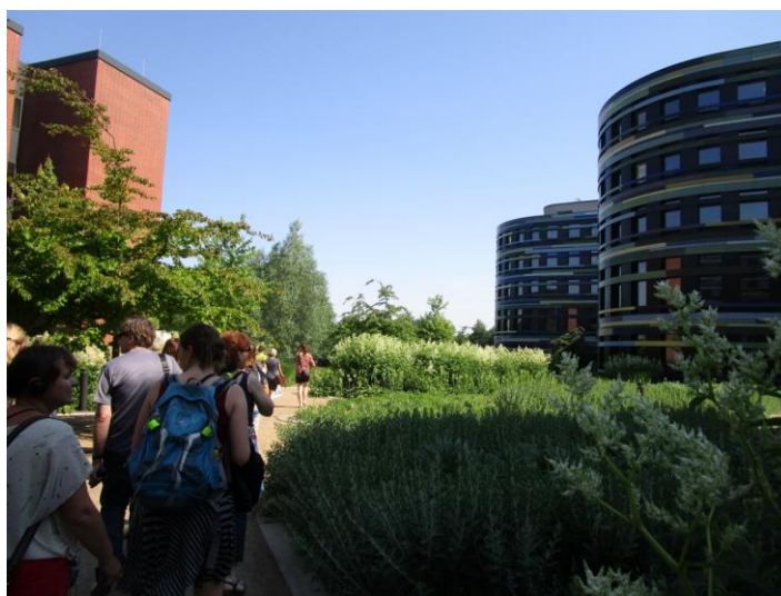
Obr. 8. Intenzivní zavlažovaná zelená střecha na budově Ministerstva životního prostředí a energetiky Kodaň.
