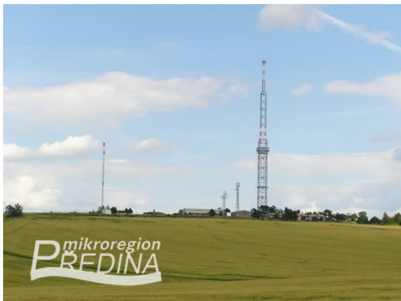
Obr. 3. Střed Moravy na kopci Předina s rozhlasovým vysílačem Brno-Dobrochov.
