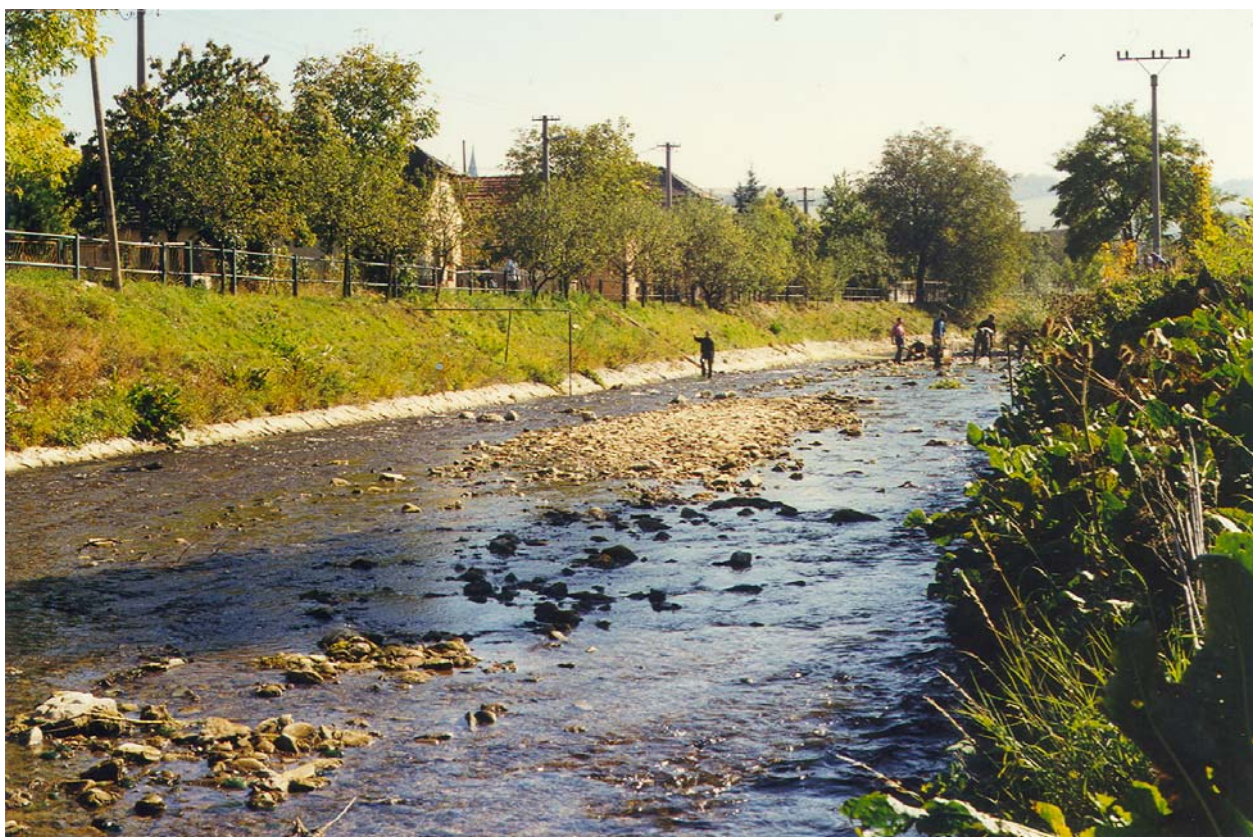
Foto č. 2: Štrková lavica v strede koryta upraveného úseku Drietomice v Drietome
