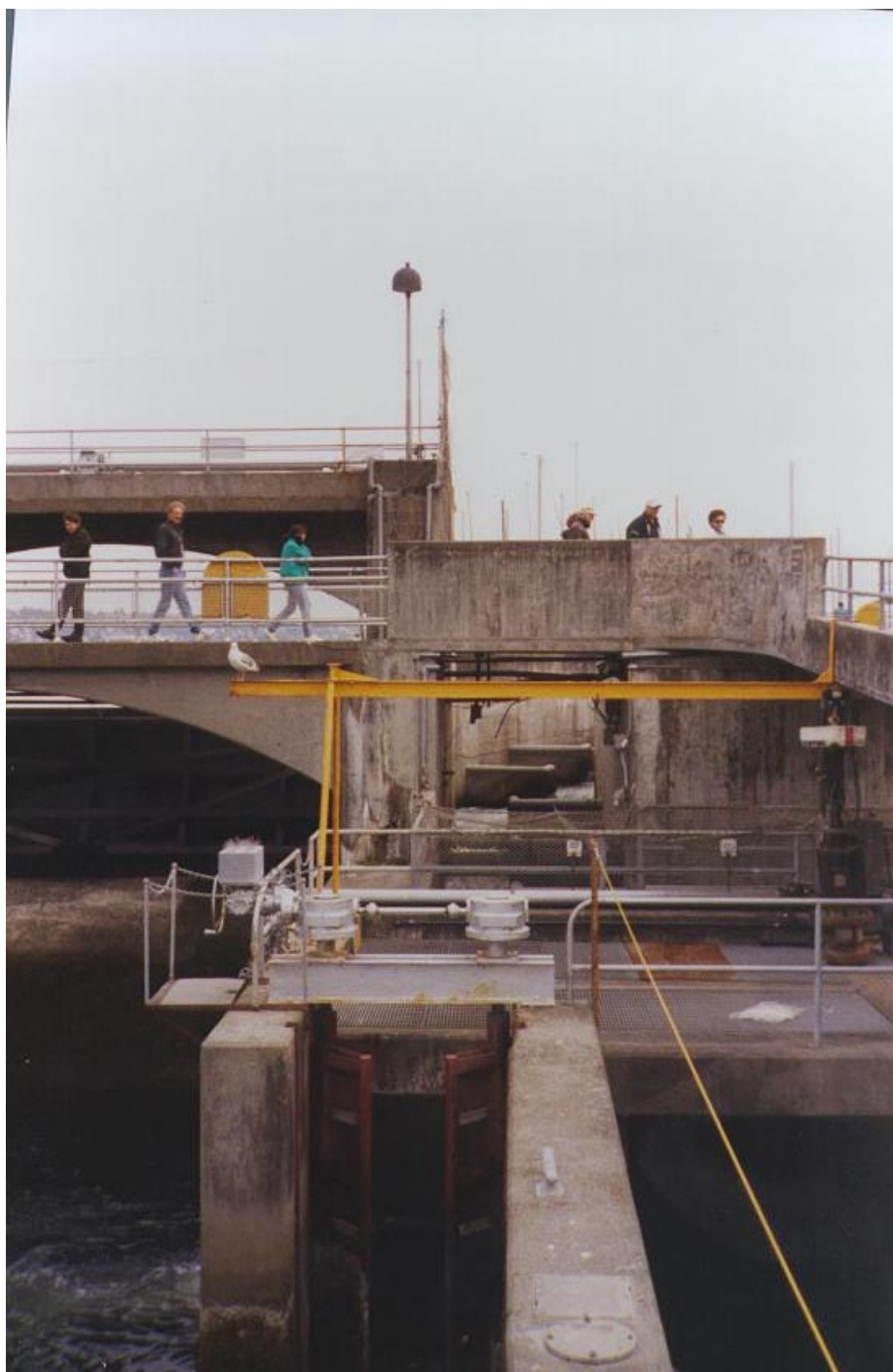
Obr.1 Vstupná brána kaskádovitého rybochodu
